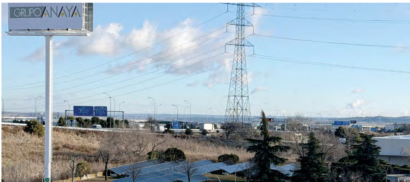
Installation de panneaux solaires sur le site logistique à Getafe en Espagne (Grupo Anaya).
